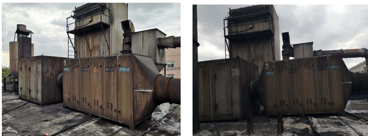
废气处理设备
